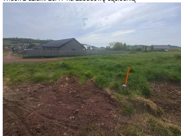
Nieruchomość w trakcie inwestycji dz. nr 29/41
