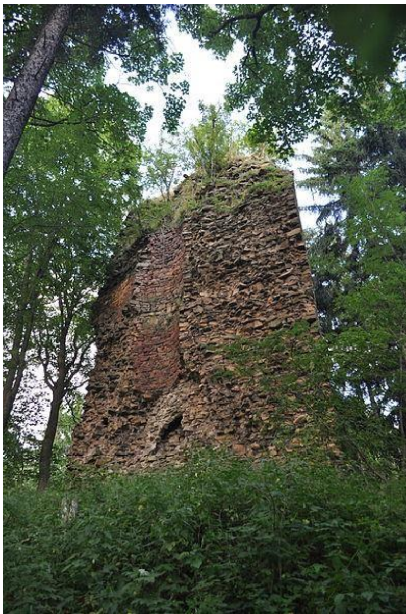
Fot. 1: Ruiny wieży zamkowej w Czarnym Borze 6
